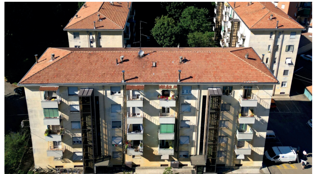
Condomini ERP di strada Navetta nel quartiere Montanara © ParmaToday, 2024
